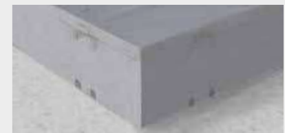
F-6. Die Platte zur Abdeckung verlegen.
