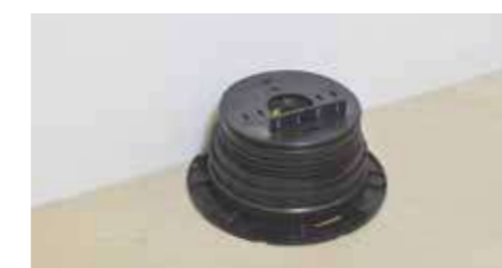
4. Montar el soporte y colocarlo con el lado cortado apoyado en la pared.
