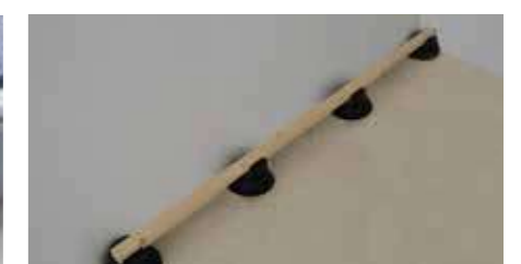
7. Verificare che il travetto sia fissato saldamente ad ogni supporto.
