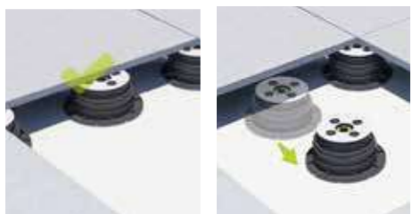
4. Nachdem die richtige Höhe erreicht ist, den Träger wieder in die Mitte einsetzen.
