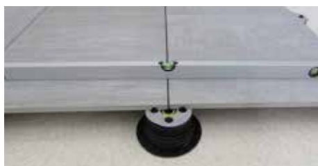
16. Vérifiez que le sol est au même niveau, linéaire.
