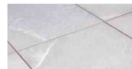
14. Pavimento sopraelevato completato.
