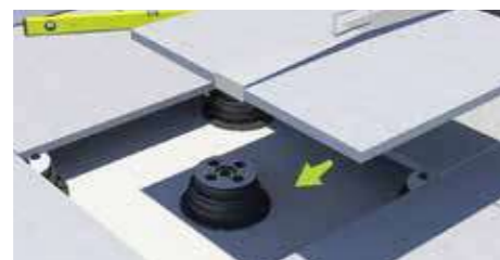
5. Colocar la baldosa.
