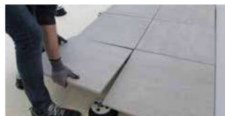
15. Posez les autres carreaux.
