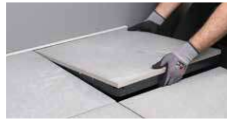
17. Verlegen Sie die letzte Reihe der Pflasterstein-/SUPATRAY-Baugruppen.
