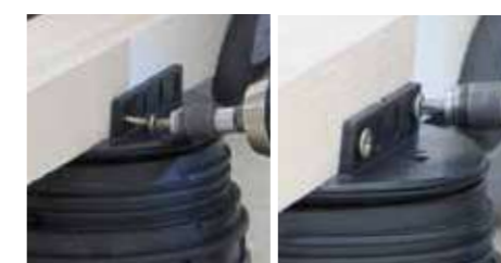
6. Avvitare il travetto al supporto attraverso le apposite fessure (utilizzare un avvitatore).
