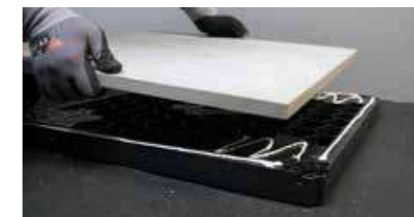
2. Posizionare la pavimentazione da 2 cm perpendicolarmente sul SUPATRAY, assicurandosi che non sporga oltre i bordi della griglia di sicurezza.
