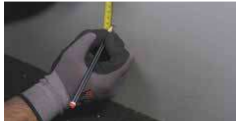
15. Utilizzare un metro a nastro per determinare l'altezza desiderata del pavimento finito.
