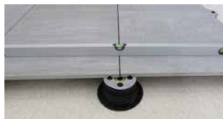
16. Verificare che il pavimento sia planare.
