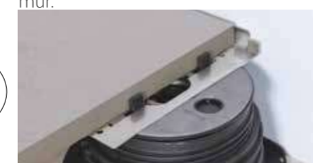
11. Posez le carreau.
