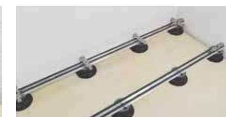
9. Continúe con la colocación para toda el área de instalación.
