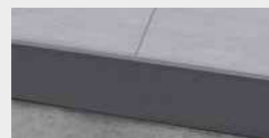
E-4. Continuar con la colocación de las baldosas.
