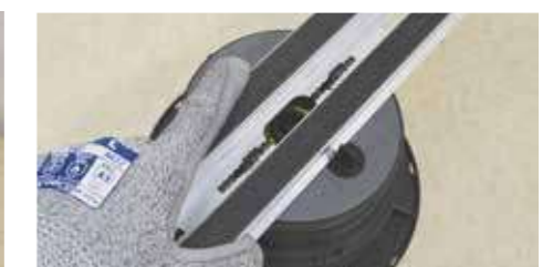
3. Setzen Sie das SUPAANG-Profil zwischen den Abstandhaltern der Stelzlager ein.
