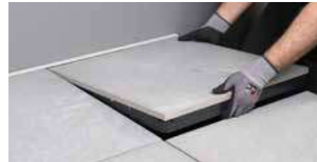
17. Posizionare l'ultima fila di assemblaggi di pavimentazione/ SUPATRAY.
