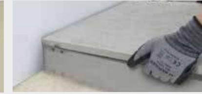
D-6. Colocar la baldosa.
