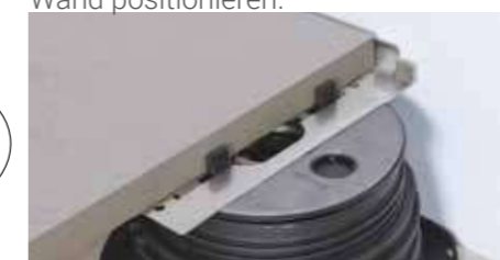
11. Die Platte verlegen.
