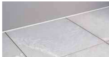
19. Pavimento sopraelevato completato.
