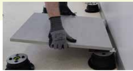
13. Die Platte verlegen.
